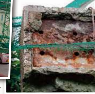
住宅地に垂れ込んだ市川ゴルフガーデンの鉄柱、土台ボルトは錆びていた © 清流舎
