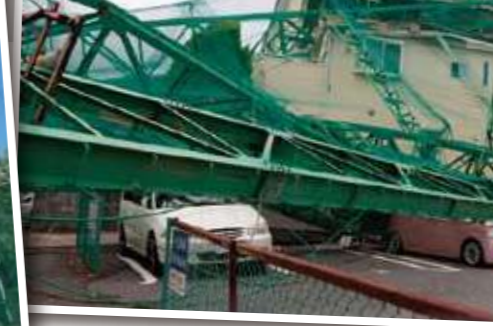
住宅地に垂れ込んだ市川ゴルフガーデンの鉄柱、土台ボルトは錆びていた © 清流舎
