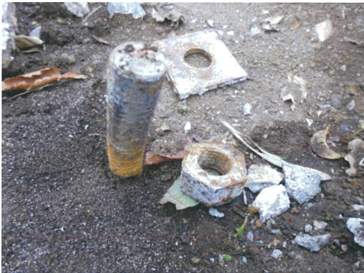
写真 3.20 発錆していないアンカーボルト
