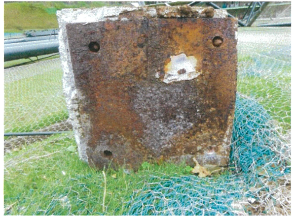
写真 3.19 ベースプレートとアンカーボルト(2)
