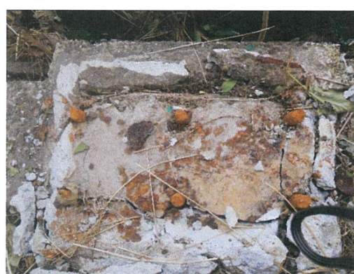
写真 3.9 柱脚ベースプレートの設置跡
