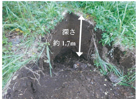
写真 3.25 柱脚の埋め込み跡
