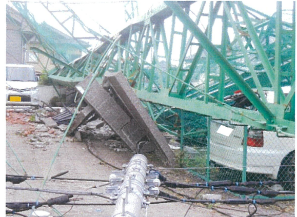
写真 3.13 ブロック塀、電柱、乗用車の被害
