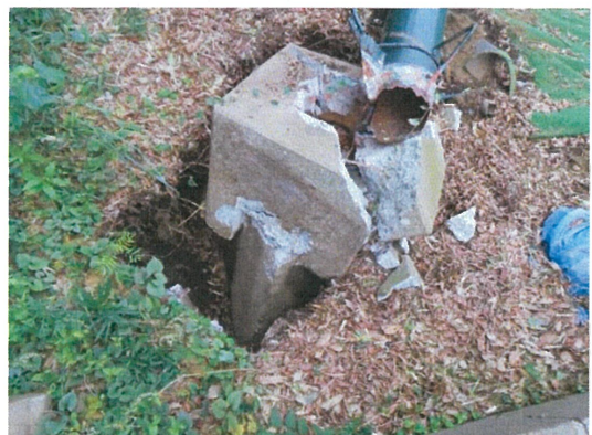
写真 3.27 柱脚の折損
