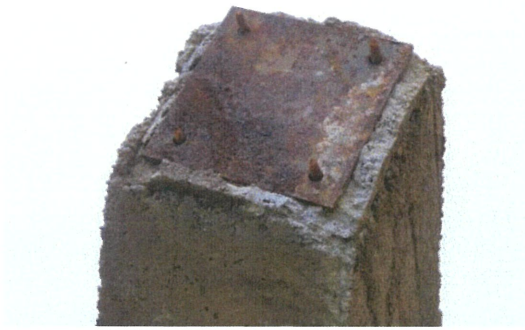
写真 3.18 ベースプレートとアンカーボルト(1)
